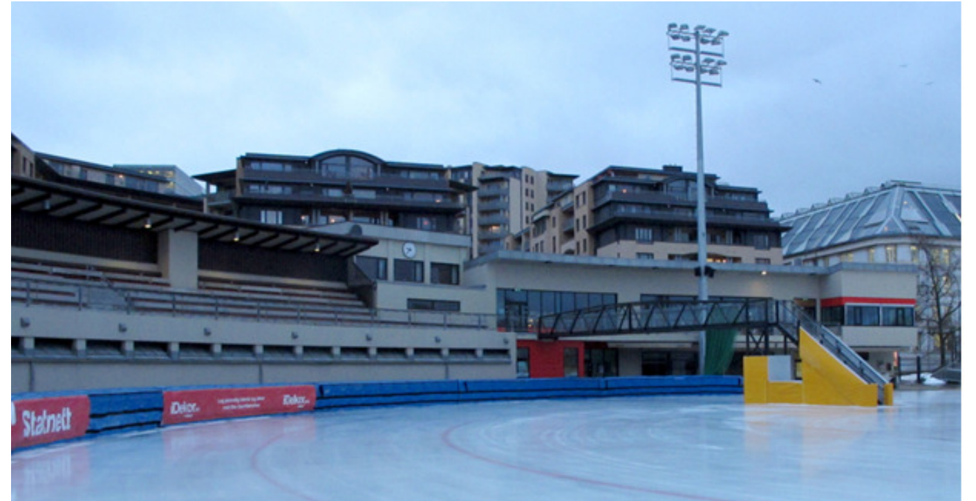
Figur 10: Eksempel på gangbro til indre bane. Billedet viser en fastmonteret bro, men det er muligt at bygge mobile løsninger. Billedet viserdesuden eksempel på sikkerhedspuder monteret på bander.
